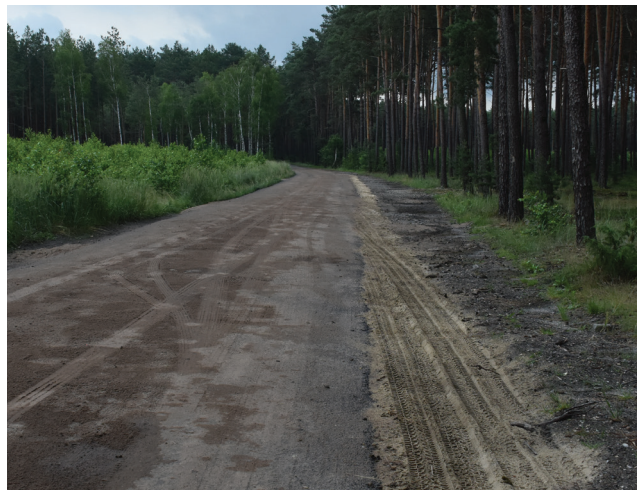
Remont drogi gminnej Łękawa - Słok (lipiec 2020)
